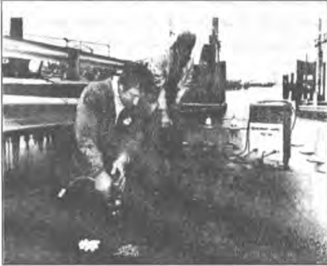
الشكل (19.4) منظومة اللحام التوتوي Crompt-Arc المستخدمة في تركيب سطح مقاوم للانزلاق
